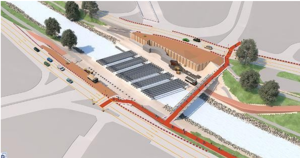
Bauphase 5 – Juli bis Oktober 2015: Die Baustellenrampe wird verlängert, die Baugruben ausgehoben und die Widerlager abgebrochen.
