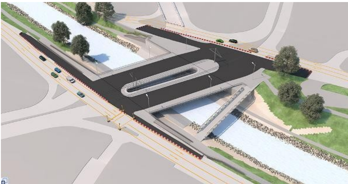
Bauphase 11 - Dezember 2016 bis April 2017: Fußgänger und Radverkehr werden zurück auf die Behelfsbrücke verlegt, Straßen- und Gleisbauarbeiten auf und hinter der neuen Brücke.
